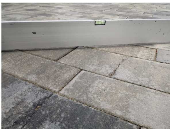
Przykład uszkodzenia nawierzchni wskutek nieprawidłowo wykonanej podbudowy (zapadanie się płyt brukowych)
