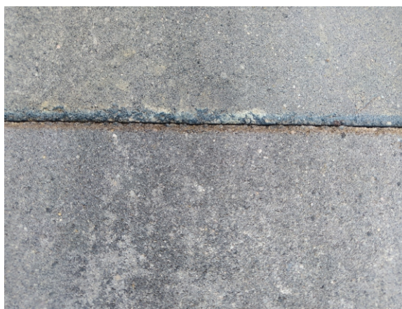
Przykład nieprawidłowej zabudowy płyt wielkoformatowych (brak odpowiednio wykonanej fugi) skutkujący powstawaniem uszczerbień na ich krawędziach
