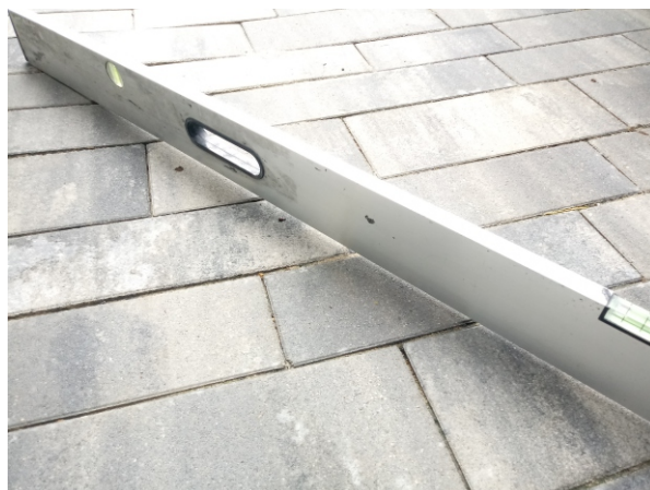
Przykład uszkodzenia nawierzchni wskutek nieprawidłowo wykonanej podbudowy (zapadanie się płyt brukowych)
