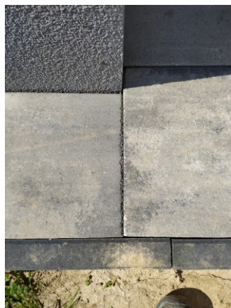
Przykład nieprawidłowej zabudowy płyt wielkoformatowych (brak odpowiednio wykonanej fugi) skutkujący powstawaniem uszczerbień na ich krawędziach
