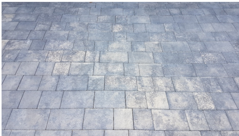
Przykład zabrudzeń na powierzchni nawierzchni z kostki brukowej powstałych wskutek składowania na niej piasku.
